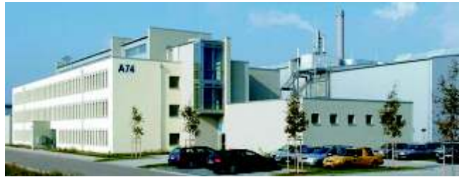
Fraunhofer Pilotanlagezentrum in Schkopau
