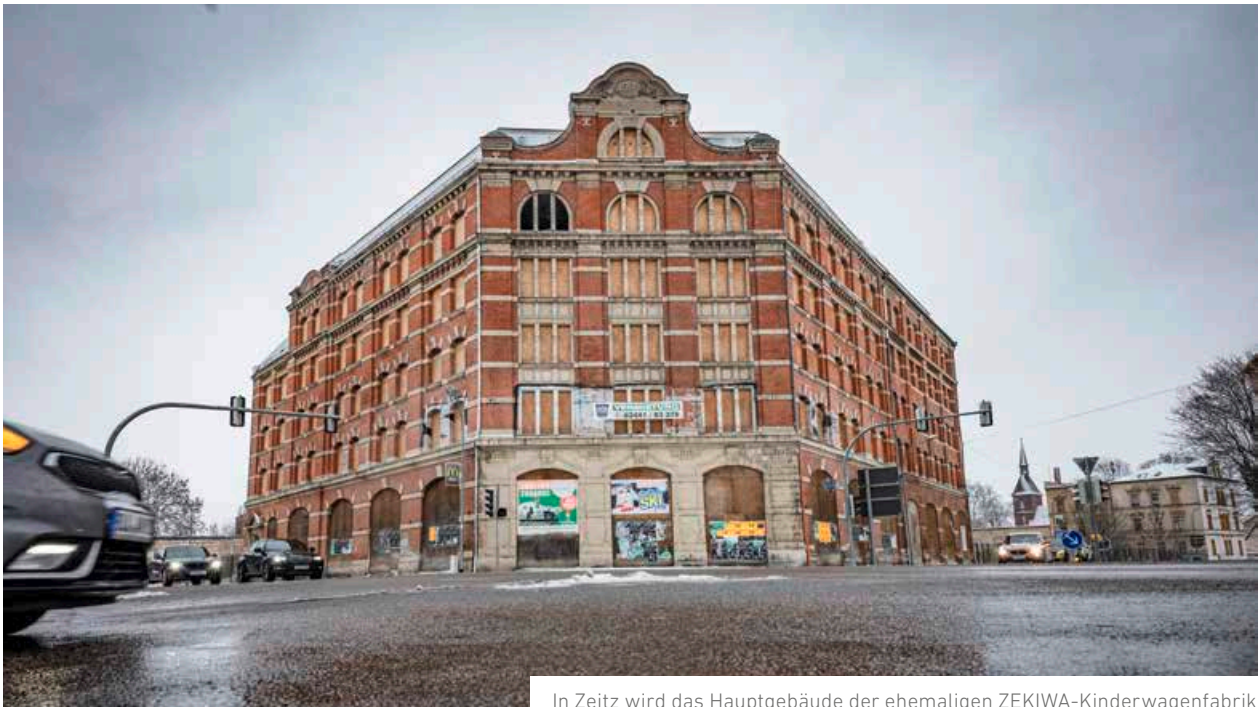
In Zeitz wird das Hauptgebäude der ehemaligen ZEKIWA-Kinderwagenfabrik saniert und bis 2021 zum Stadtarchiv umgebaut.
