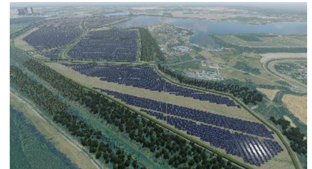
MoveOn Energy GmbH – Energiepark Witznitz, Erzeugung von H 2 geplant
